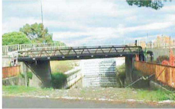
Il cantiere dell'Incile visto dal ponte che sarà demolito
