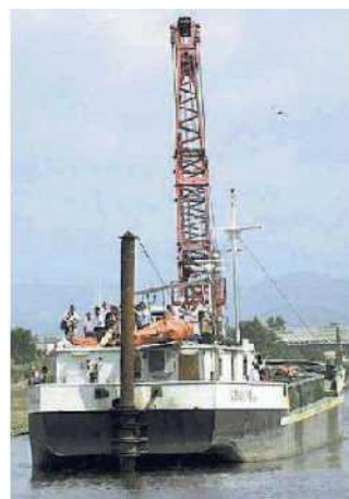
Dragaggio del canale
